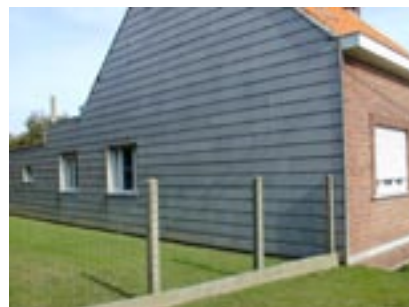
Revêtement de façade en amiante-ciment
